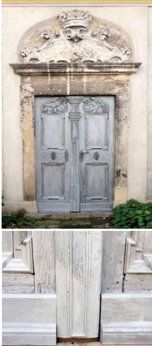
**Fig. 10** Porta di legno del castello Batzdorf (vicino Dresda), trattata con nanosol silice modificato / Wooden door at castle Batzdorf (near Dresden) treated with modified silica nanosols
