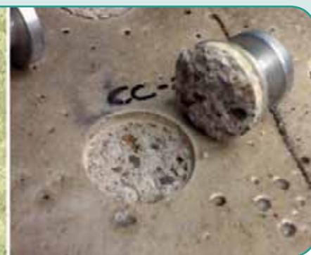
Fig. 4 Adhesion of WB-1 based primer to damp concrete Adesione di un primer a base di WB-1 per impregnare il calcestruzzo
