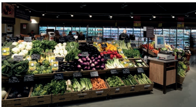
Full LED lighting system and fridge counters provided with doors - Carrefour Store, Piazzale Siena, Milan Sistema di illuminazione Full LED e banchi frigo dotati di sportello dello store Carrefour di Piazzale Siena, Milano
