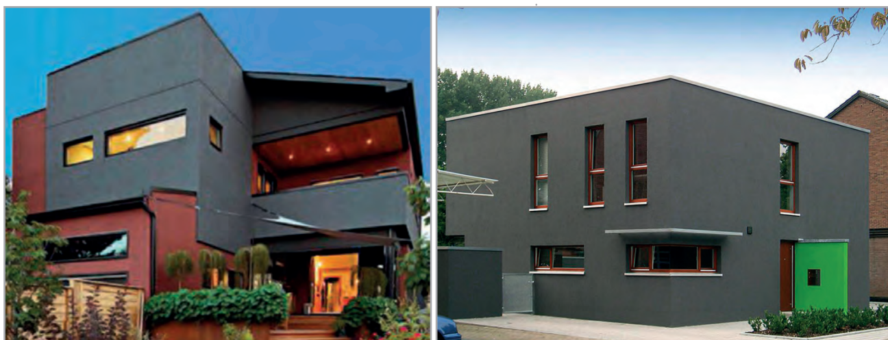
Fig. 4 Examples of buildings with dark wall colors Esempi di edifici con tinte murali scure
