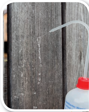
Fig. 5 - Weathering test: these boards were left outdoors for 17 years. The surface of the untreated board (left) is now so porous that water penetrates it immediately. On the board beside it, on the other hand, the water rolls off in beads. The boards treated with Silres® WH are still protected by the silicone resin's water repellency Test di esposizione agli agenti atmosferici: per 17 anni queste tavole sono state esposte all'azione degli agenti atmosferici. La superficie della tavola non trattata (a sinistra), nel frattempo, ha i pori talmente aperti che l'acqua vi penetra immediatamente. Nella tavola accanto invece, l'acqua scivola via dalla superficie. Le tavole trattate con Silres® WH sono ancora protette dall'azione idrorepellente della resina siliconica
