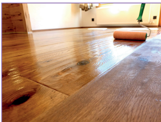
Fig. 2 - Without a coating, UV light can interact with wood surfaces, causing discoloration and damage Senza rivestimento, la luce UV può interagire con le superfici di legno causando perdita di colore e danneggiamenti
