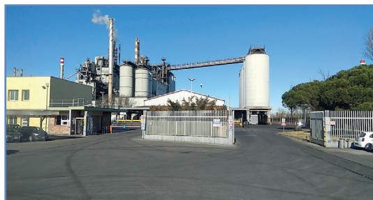
Cabot plant in ravenna, Italy Impianto Cabot di Ravenna, Italia
