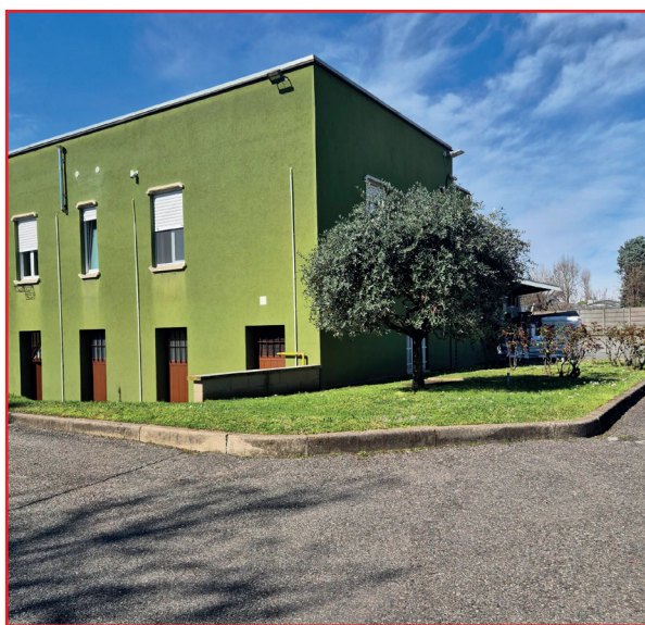
Cominder headquarters in Novate Milanese, Milan Sede principale di Cominder a Novate Milanese, Milano
