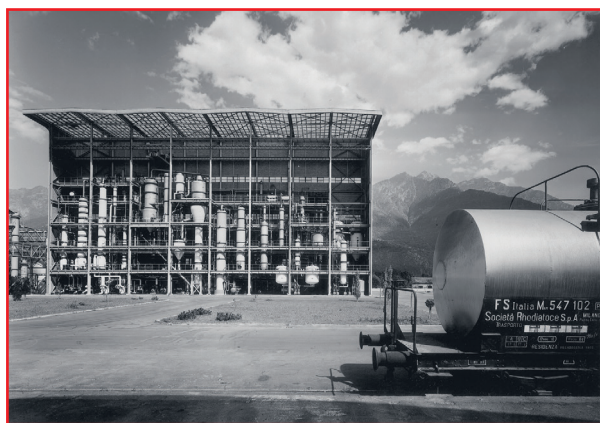
Acetaldehyde plant - Picture from the sixties Impianto di acetaldeide - Foto anni '60
